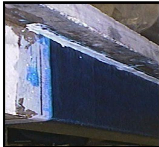
(d) Filling the groove with epoxy paste
