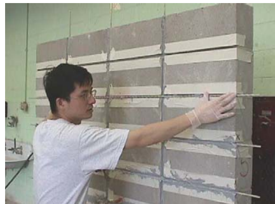
(d) Installation of GFRP Rods
