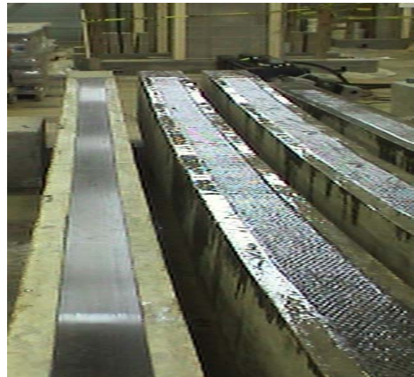
(d) Beams after strengthening
