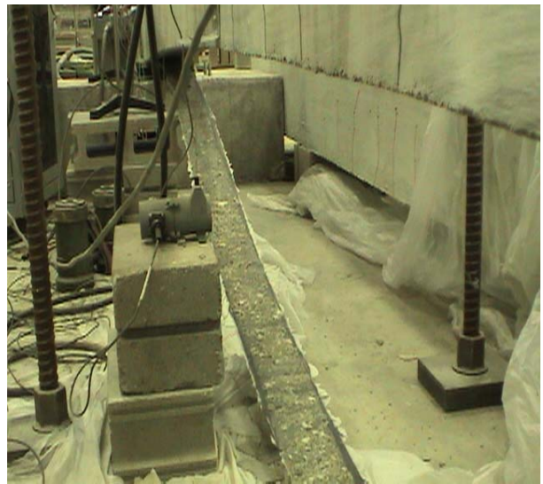
(d) Beam 5 after failure
